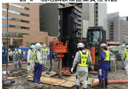
図-3 改良体造成状況
