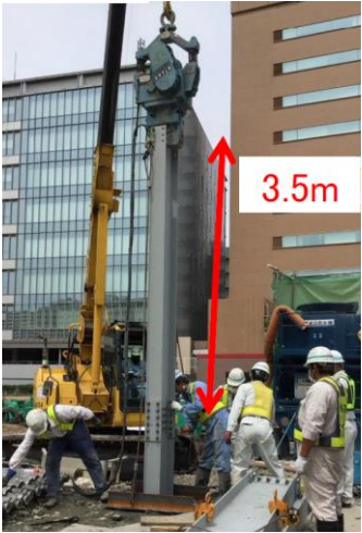
図-5 芯材挿入状況
