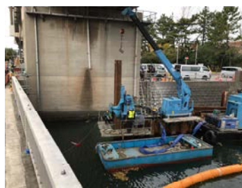
写真-6 鋼矢板打設状況
