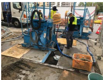
写真-2 薬液注入工
