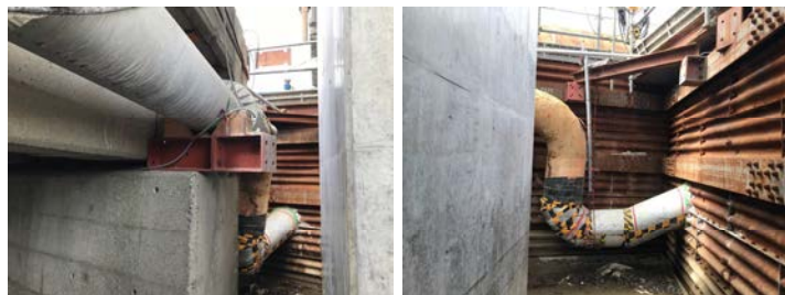
写真-4 ガス管受け防護
