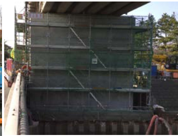
写真-7 生コン打設完了
