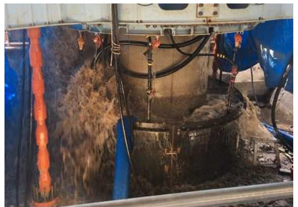
写真-1 壁式エアリフト施工状況
