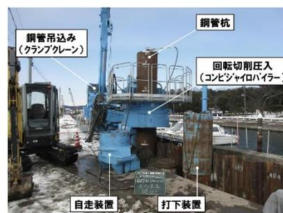
図-5. 鋼管杭の施工
