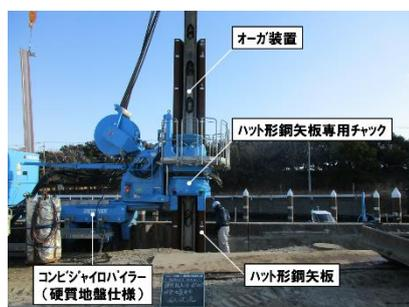
図-3. ハット形鋼矢板の施工
