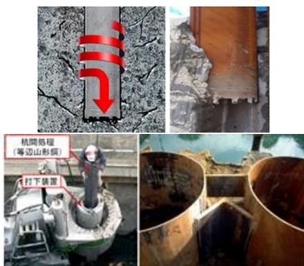
図-1. 回転切削圧入と杭間処理
