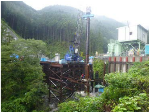
写-1 鋼管杭打設状況
