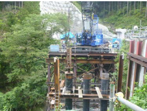
写-2 衝撃載荷試験状況
