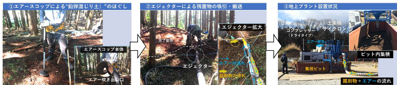
写真-2 エアー式土砂掘削・搬送システムによる施工状況フロー
