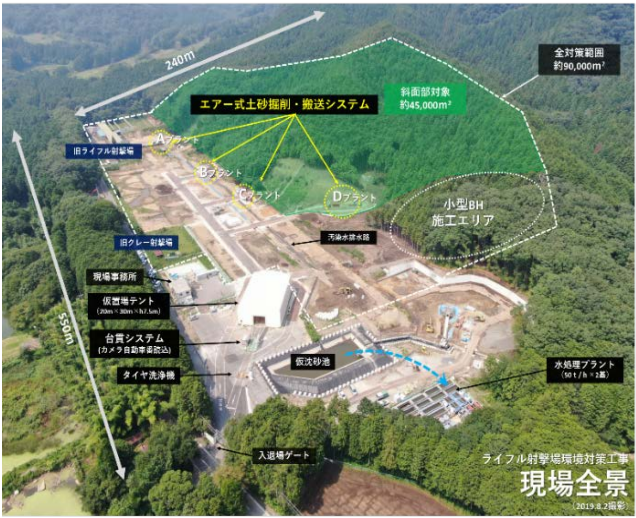
写真-1 現場全景
