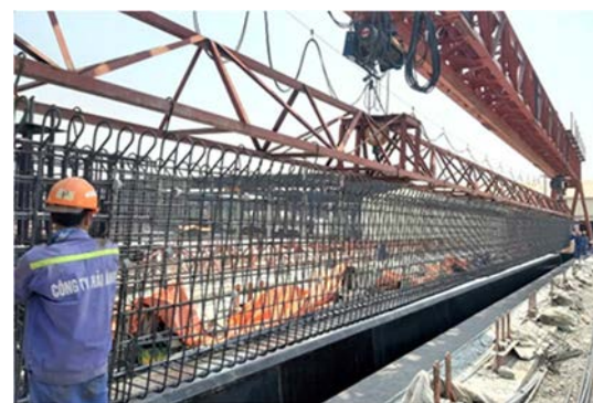
写真 2 プレハブ鉄筋吊り込み状況
