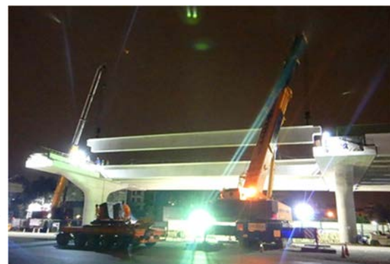
写真 3 PC 桁架設状況
