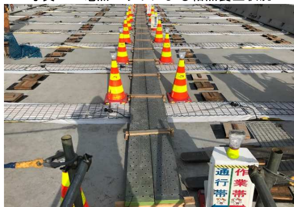
写真-2 現場での養生状況
