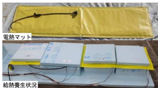
写真-1 電熱マットによる給熱養生状況
