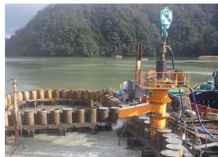
(写真.4.2) 改良したダウンザホールハンマ架台
