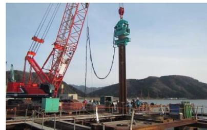
(写真.3.3) 鋼管杭打設状況
