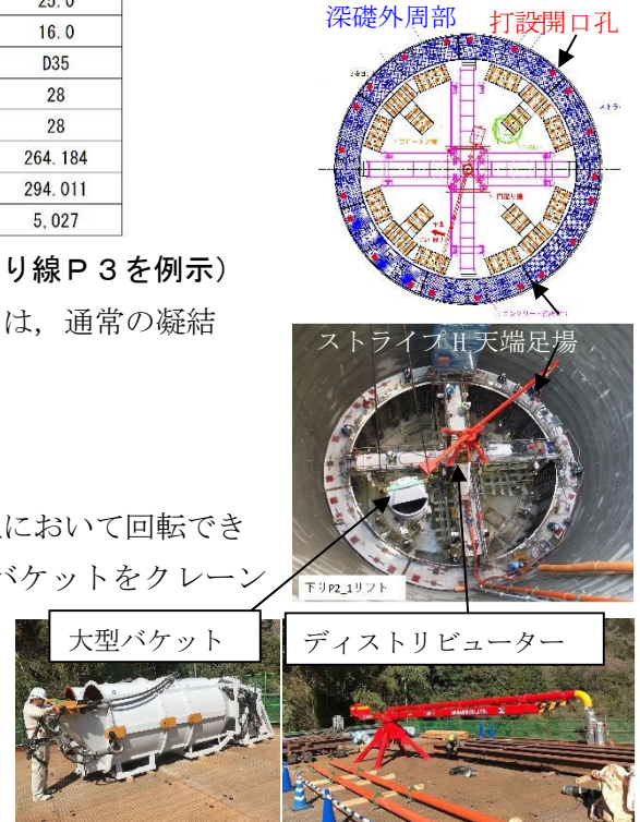
図-5 大口径深礎打設概要図(1)
