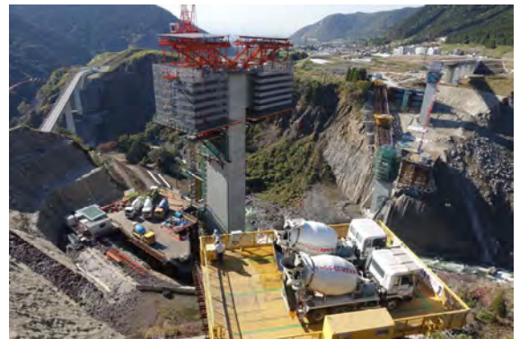
写真-1 インクラインによる資機材運搬
