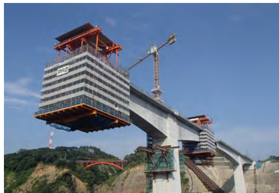
写真-5 超大型移動作業車による張出架設
