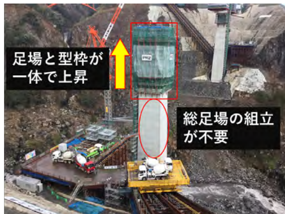
写真-4 クライミングシステムによる橋脚施工
