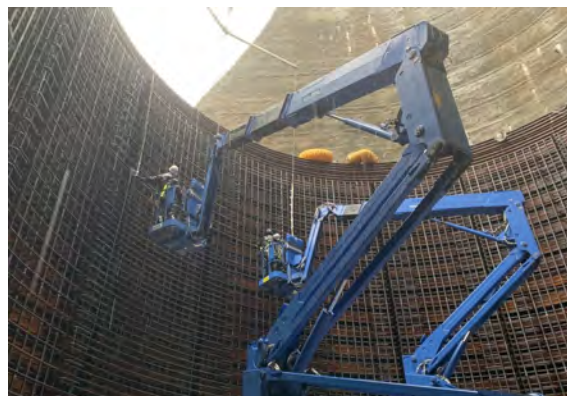
写真-3 高所作業車による深礎鉄筋の組立
