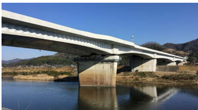
写真-5 完了全景
