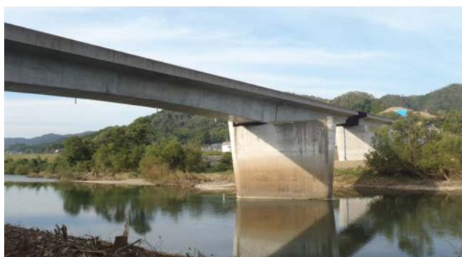
写真-5 着手前全景
