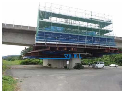
写真-2 柱頭部施工状況
