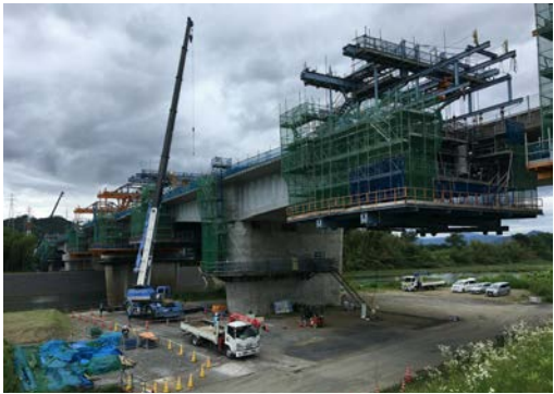
写真-1 河川内張出施工状況
