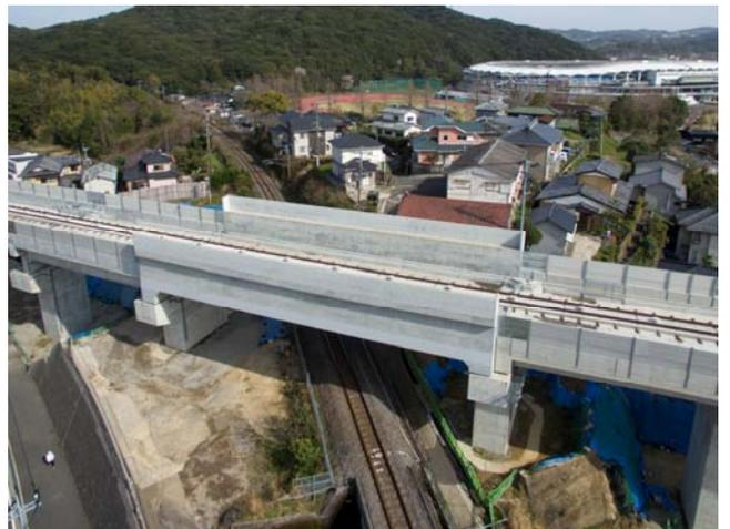
写真-3 PC下路桁構築完了
