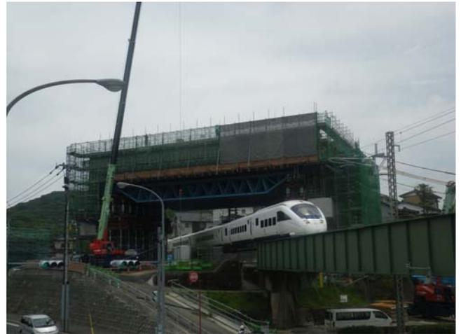
写真-1 PC下路桁構築時
