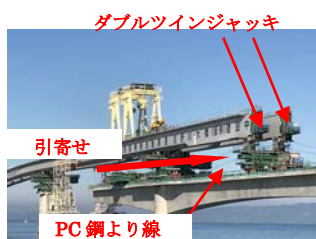
写真-4 牽引設備
