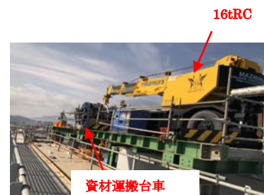
写真-2 資材運搬台車および 16tRC 台車
