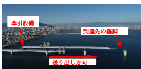
写真-3 送り出し作業全景
