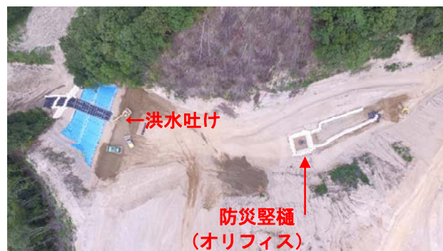
写真-2 仮設調整池 堰堤盛土復旧状況
