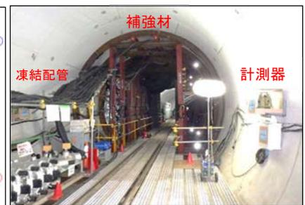
写真-1 補強材・計測器設置状況
