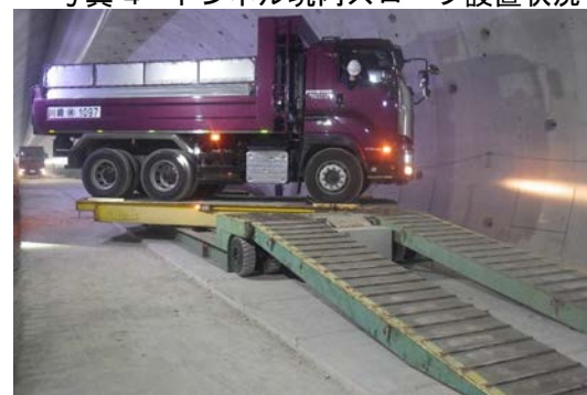
写真-5 ターンテーブル使用状況
