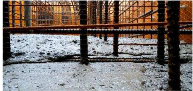
写真-6 梁幅部の打込み状況
