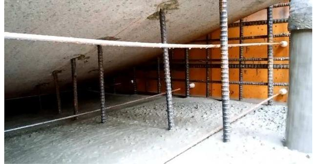
写真-5 梁下の打込み状況
