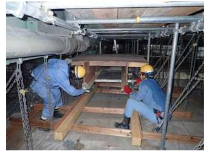
写真-2 木材によるパネル運搬試験
