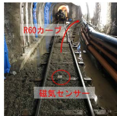
写真-4 速度制限箇所
