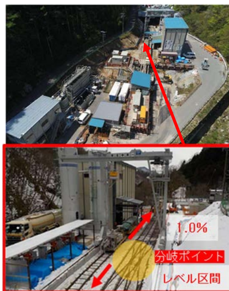
写真-1 小黒川えん堤プラントヤード
