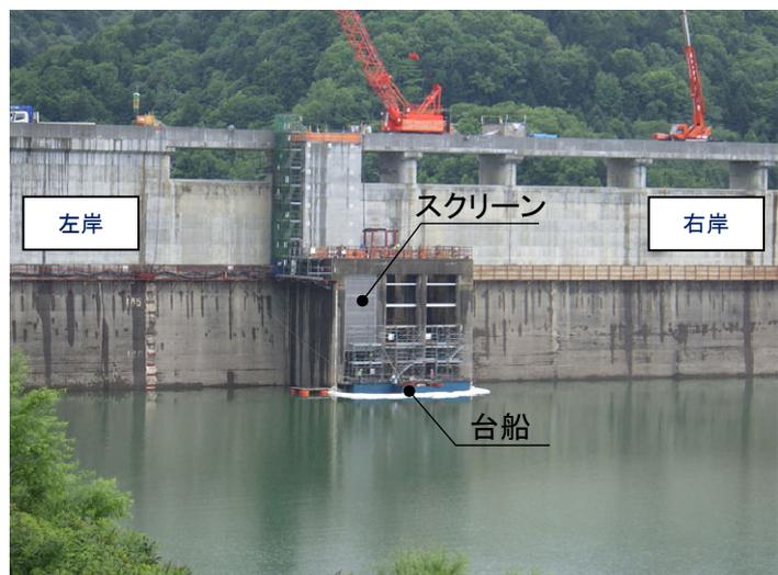
写真-2 台船足場によるスクリーン設置状況(上流から撮影)
