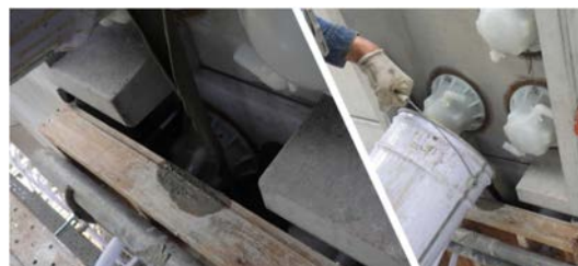
写真-1 切欠き箇所 無収縮モルタル注入状況
