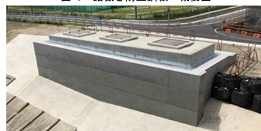
写真-2 ニューマチックケーソン+さや管沈設完了
