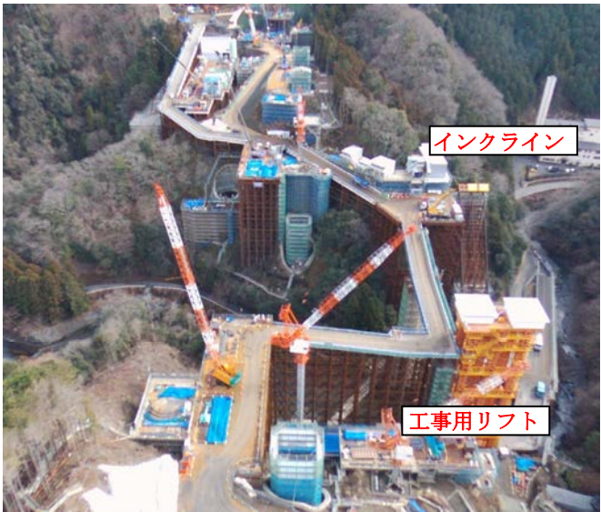
写真-1 工事用道路全景
