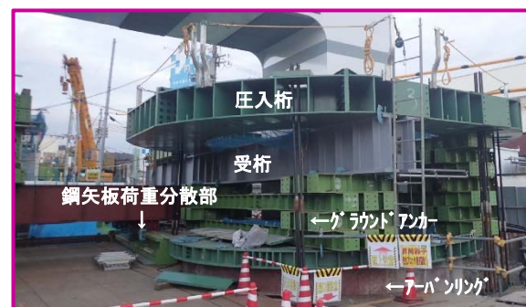
図-7 ベント基礎写真
