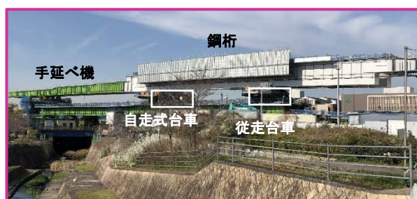
図-3 架設前状況
