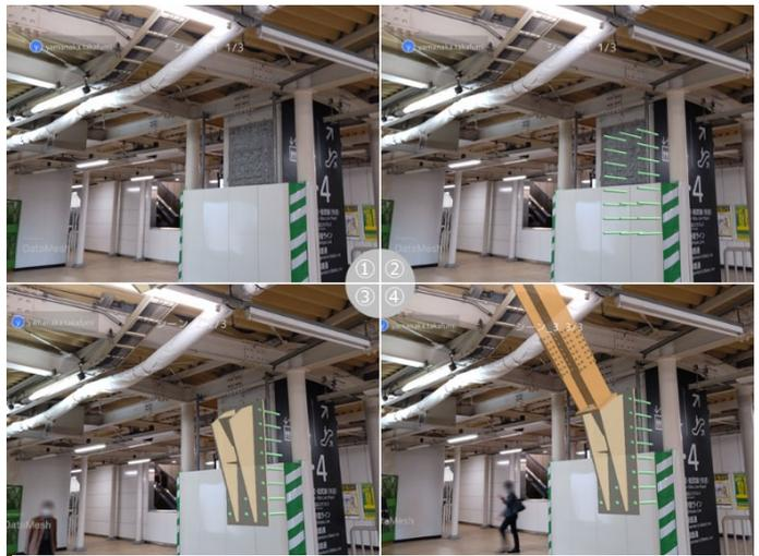
写真-2 MR適用事例（補強斜梁の設置手順）
