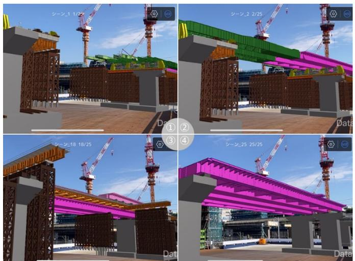
写真-4 MR適用事例（桁の送り出し手順）
