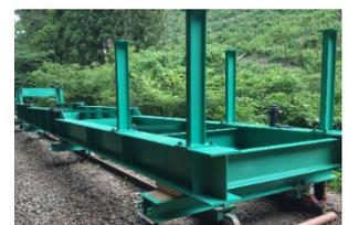
Step1: 桁扛上・パイロット桁の接続
