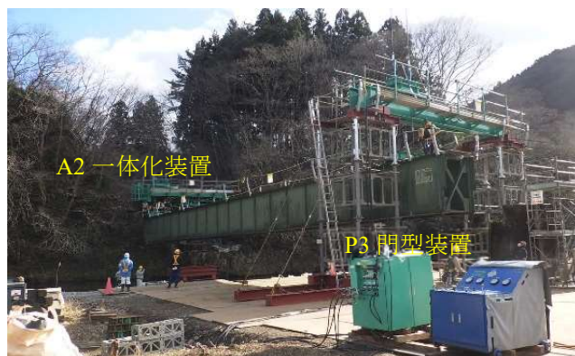
図-6 横取り降下状況
