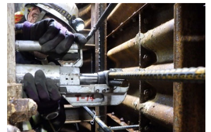
写真1 継手施工状況
