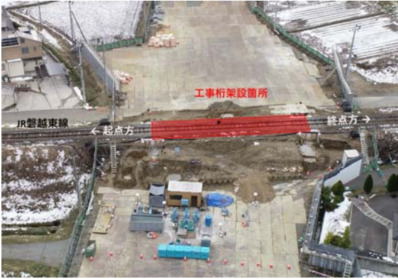
写真-1 工事桁架設前
