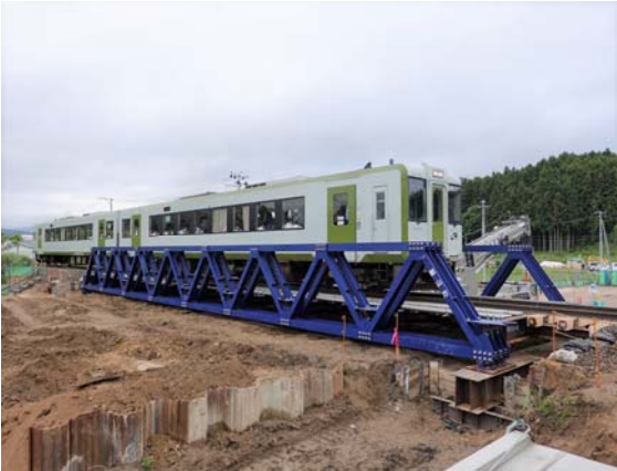
写真-5 工事桁架設後
