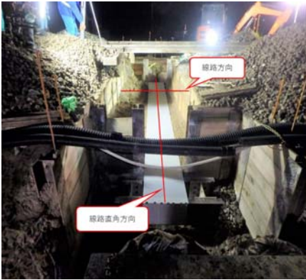
写真-3 転写フィルム使用状況
