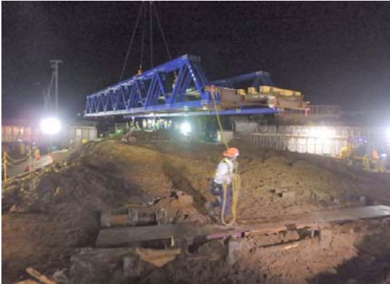
写真-4 工事桁架設状況
