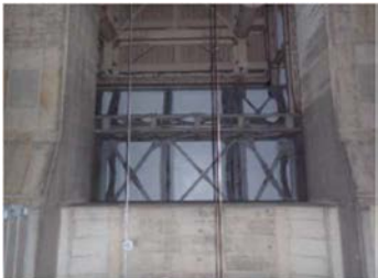
写真-5 施工後写真(近景)
