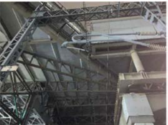
写真-6 施工後写真
