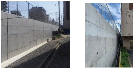
写真-3 RRR パネル完了
