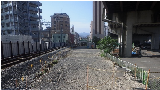
写真-1 工事場所 [着手前]
