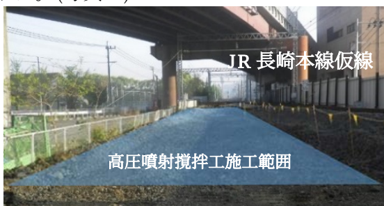
写真-2 高圧噴射攪拌工 [着手前]
