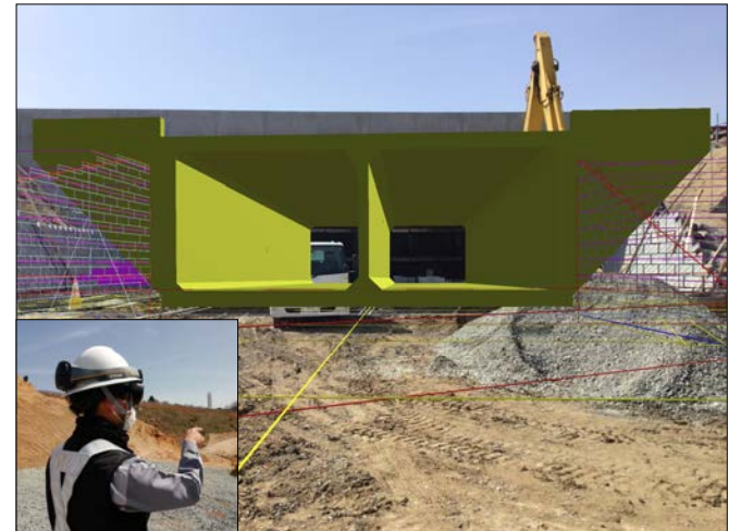
写真-3 3次元モデルの施工イメージ確認状況
