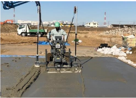
写真-2 コンクリート均し 機械の適用状況
