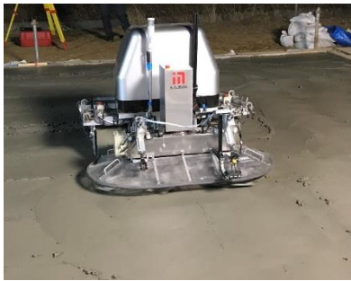
写真-3 コンクリート仕上げ ロボット適用状況
