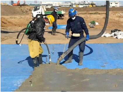
写真-1 ウェアラブル バイブレータの適用状況
