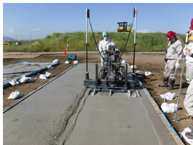
写真-3 コンクリート均し機械の適用状況 (その2)
