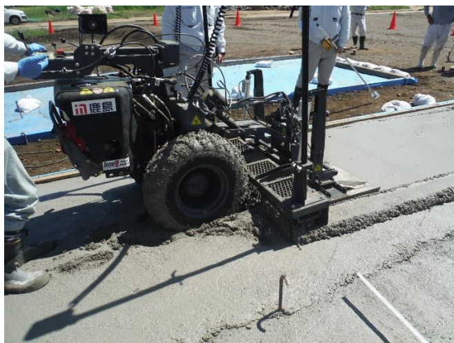
写真-2 コンクリート均し機械の適用状況 (その1)
