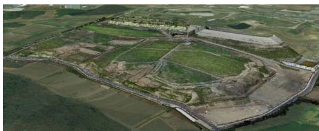
図 3-1 3 次元地形（工事着手前）
