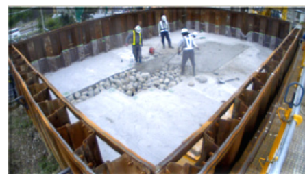
図3 掘削地盤の造成状況
