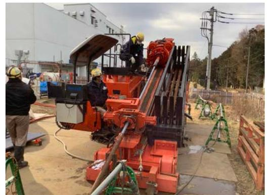
写真-3 塩ビ管挿入状況
