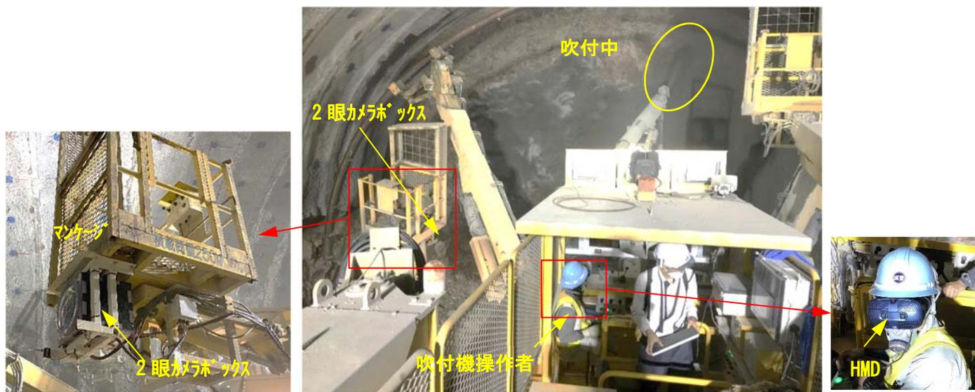
写真-4 HMD 遠隔吹付状況
