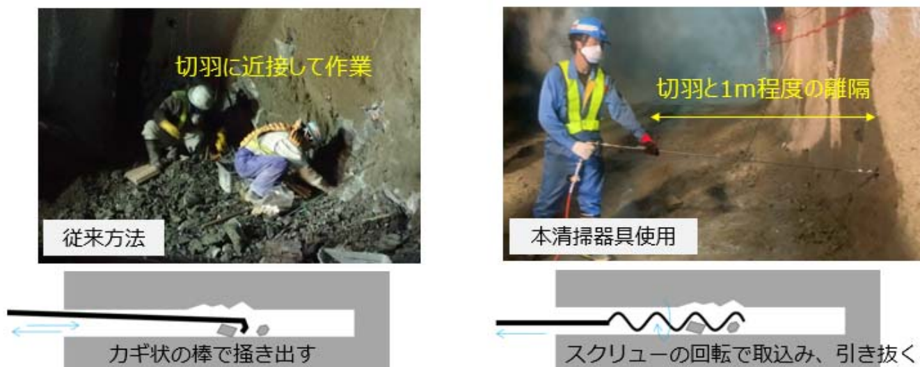
写真-1 作業状況比較
