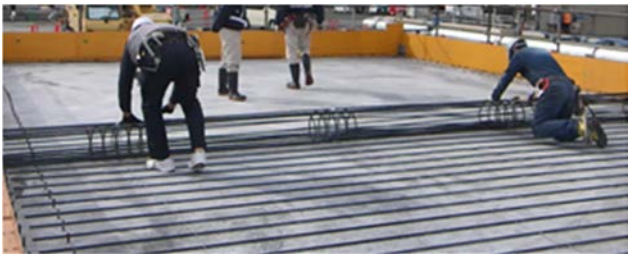
写真-3 鉄筋作業の状況
