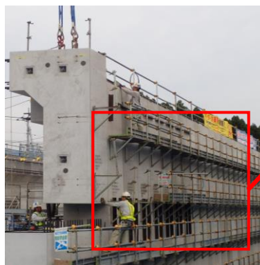
写真-1 ブラケット足場材設置状況
