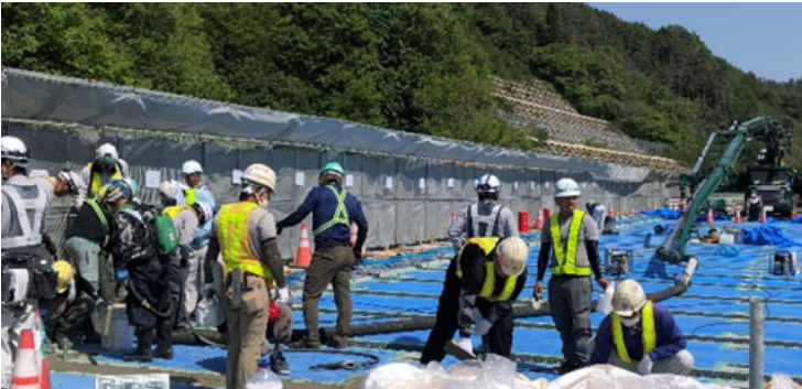
写真-1 2 ブロック打込み状況
