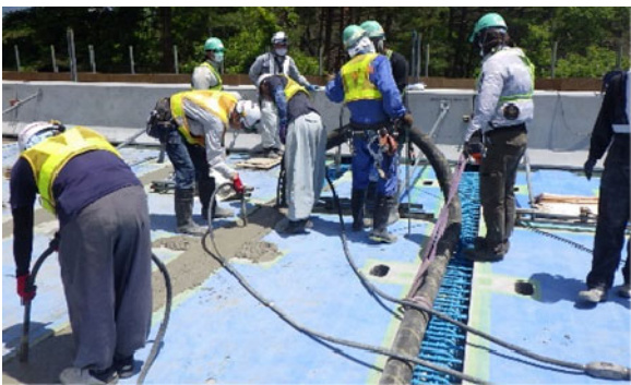
写真-2 2 ブロック締め固め状況
