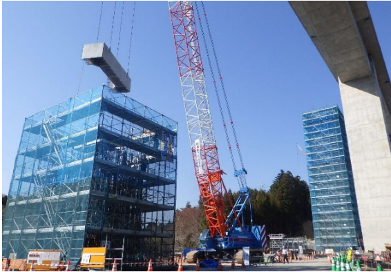
写真-1 施工状況
