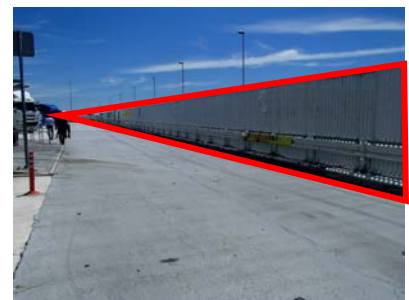
図-3 第一 PA 既存のフェンス
