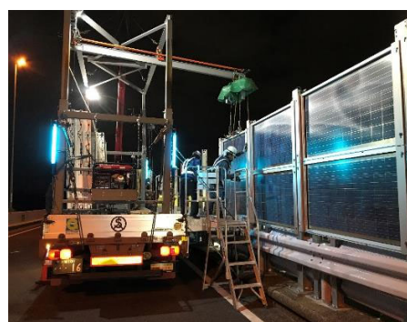
図-5 太陽電池パネル取付け装置による施工
