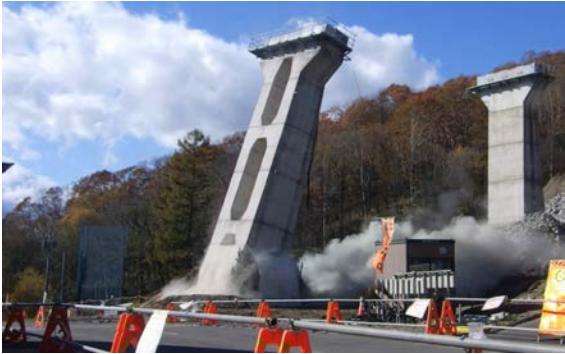
写真-2 P4 橋脚の発破解体の状況（右側は P3）
