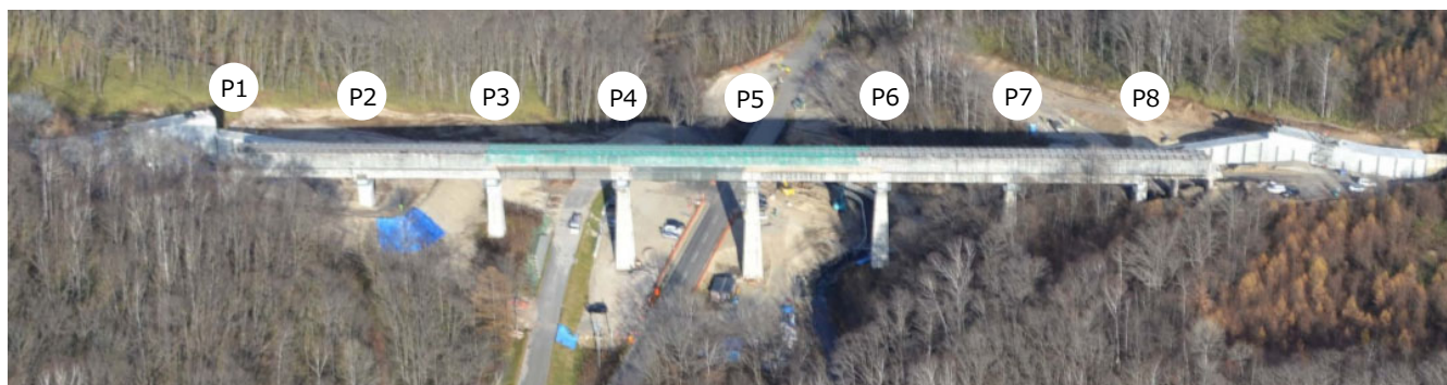
写真-1 茂喜登牛水路橋の外観
