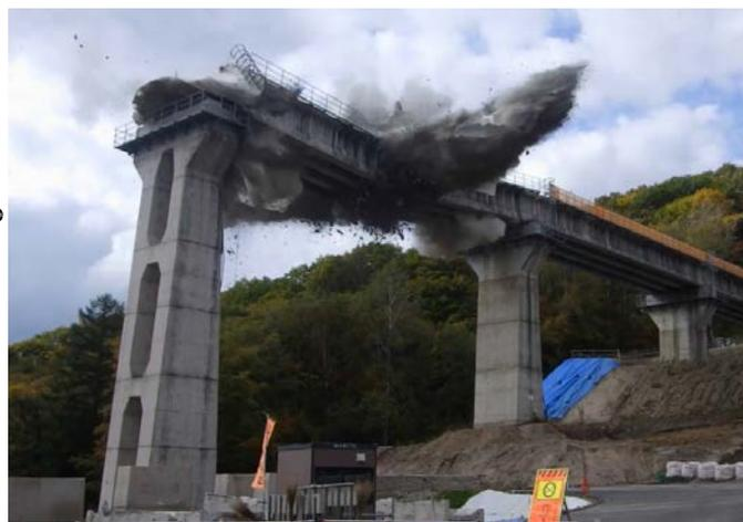
写真-1 桁の発破状況 (P3-P4 桁)
