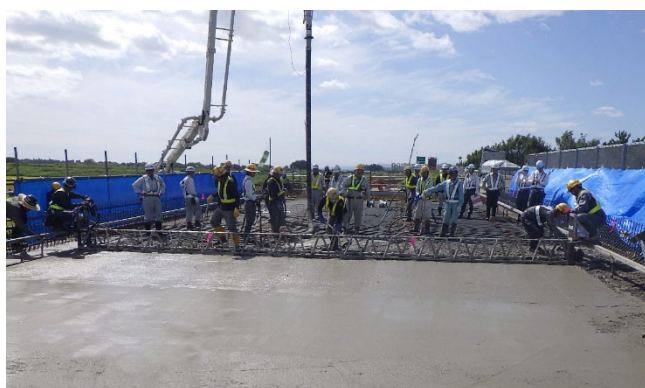
写真-2 コンクリートフィニッシャーによる敷き均し状況
