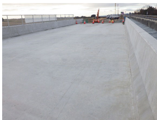
写真-3 床版仕上り状況
