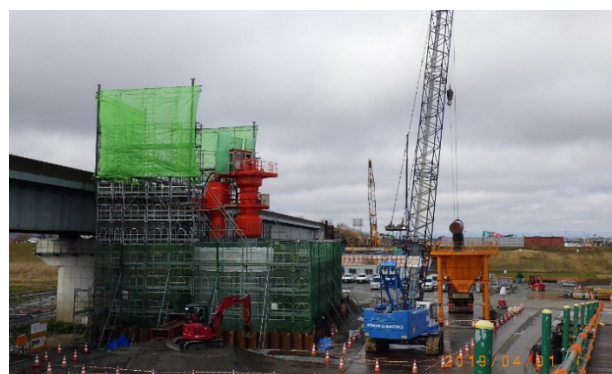
写真 3 沈下掘削状況 (P4 橋脚)
