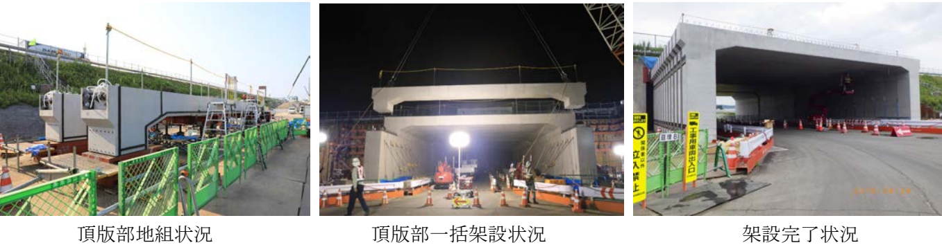
図4 プレキャスト門型カルバートの構造比較
