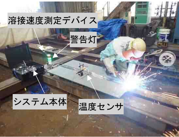
写真－5 検証試験状況（工場、手動溶接）
