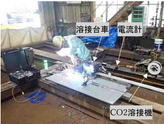
写真－6 検証試験状況（工場、溶接台車）
